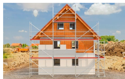
Utilizzo in cantiere.
